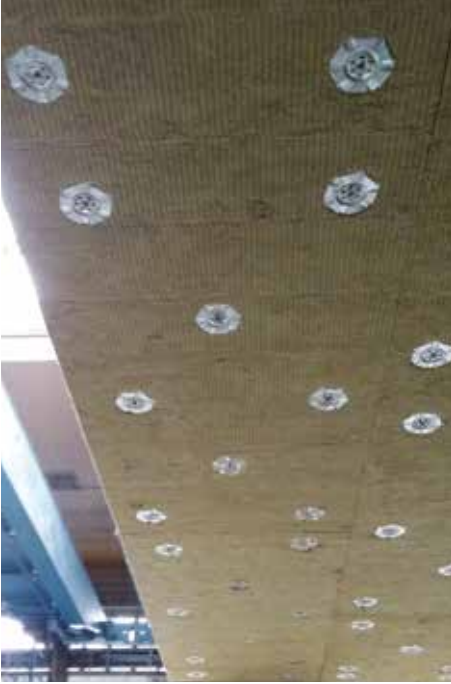
Palosuojattu betonilaatta.
