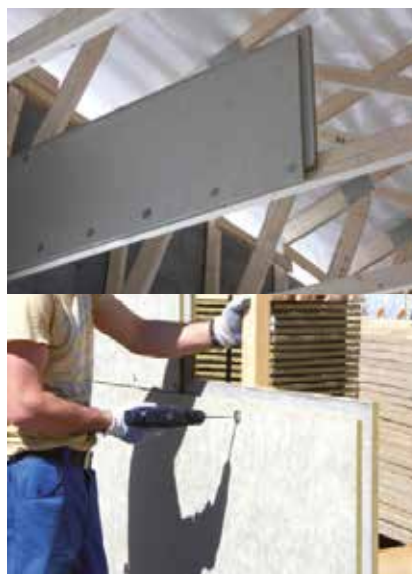
FireSAFE PR30 levyn kiinnitys puuruuveilla ja aluslevyillä kattoristikoon. Levyjen asennus on helppoa ja sujuvaa ruuviväännintä käyttämällä.
